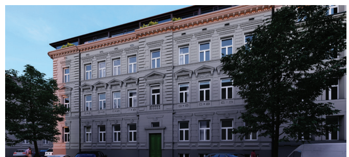
BYTOVÝ DŮM PLZEŇ
